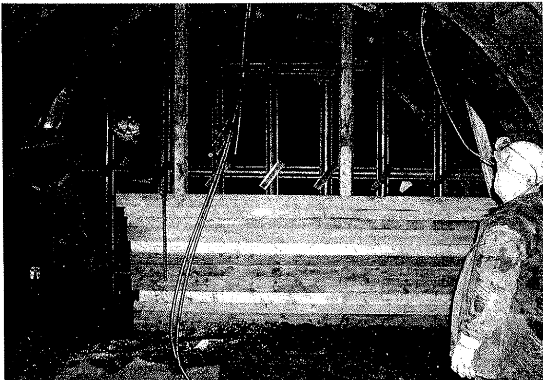
Petrovická úpadní – stavba opěrné zdi – září 2006
