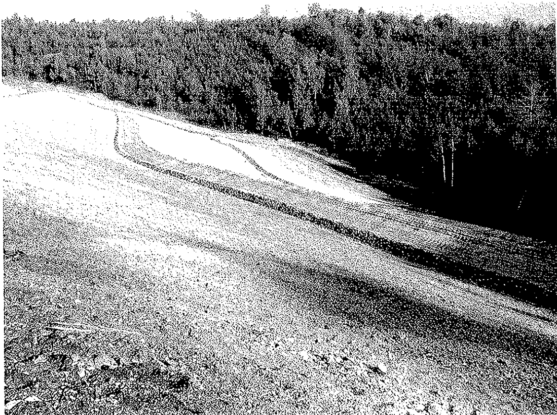
Odval V Němcích, vých. svah – po dokončení
