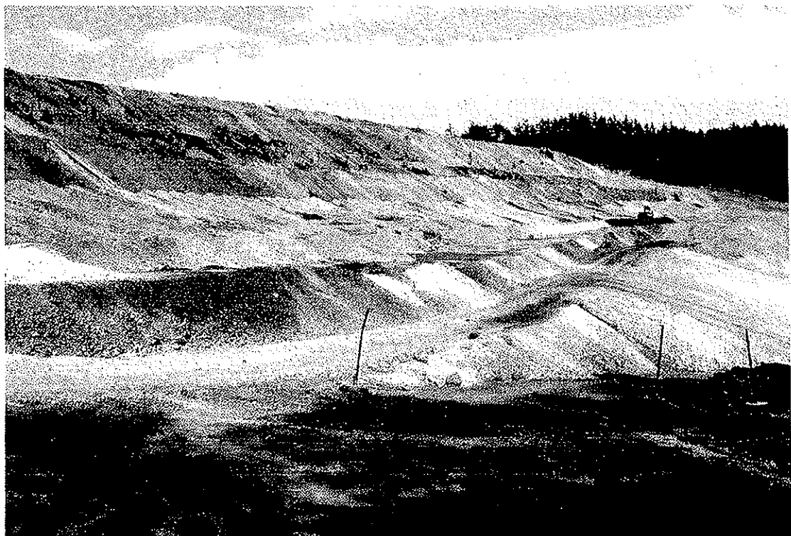
Odval V Němcích, návoz materiálu pro zajištění stability vých. svahů
