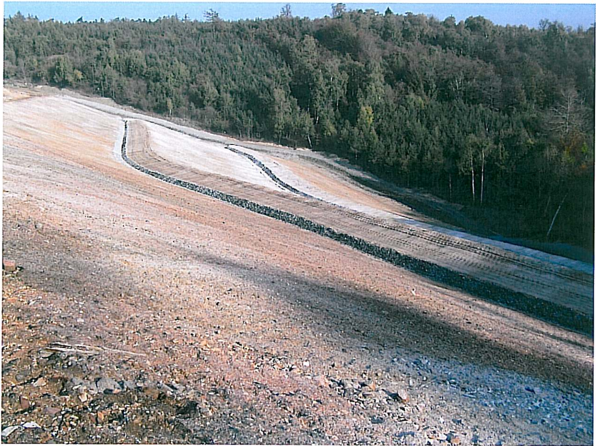
Odval V Němcích, vých. svah – po dokončení
