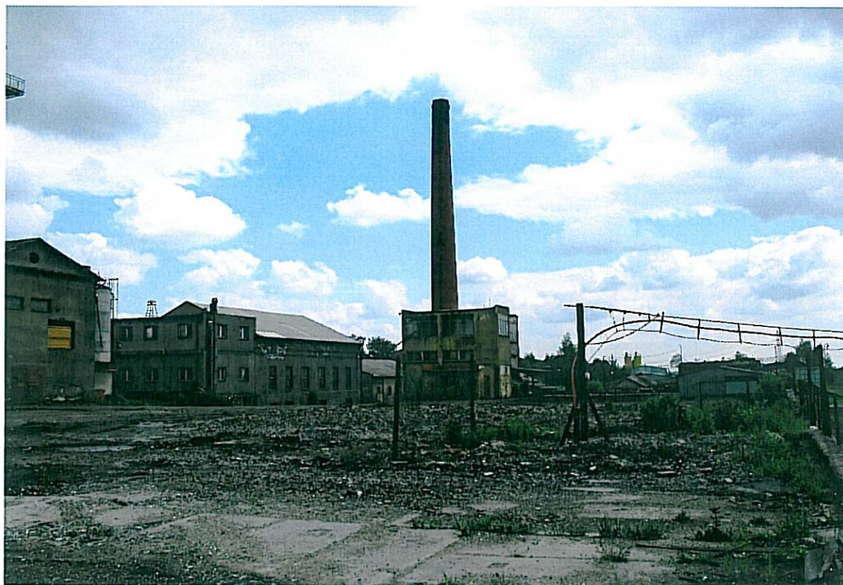
Plocha po demolici úpravny
