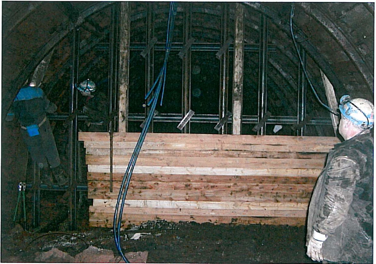
Petrovická úpadní – stavba opěrné zdi – září 2006
