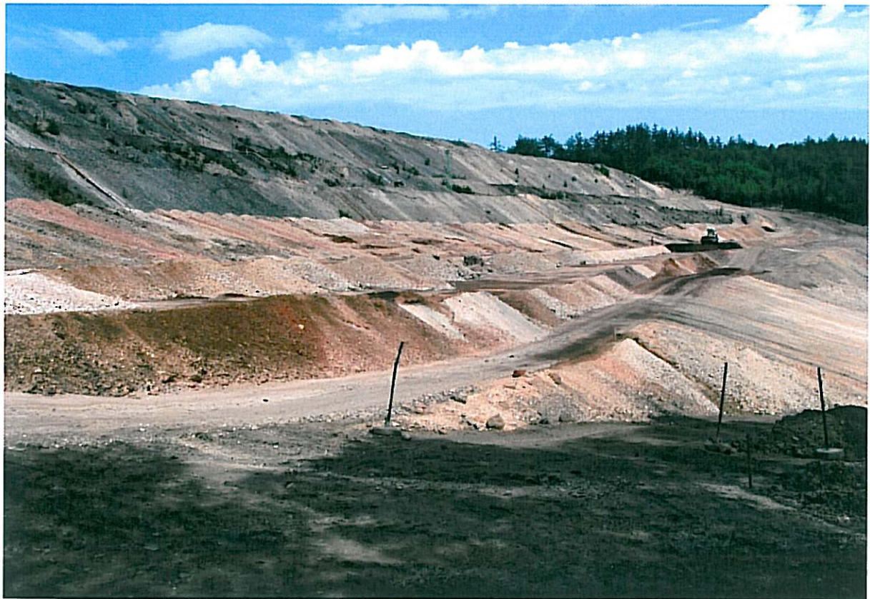
Odval V Němcích, návoz materiálu pro zajištění stability vých. svahů
