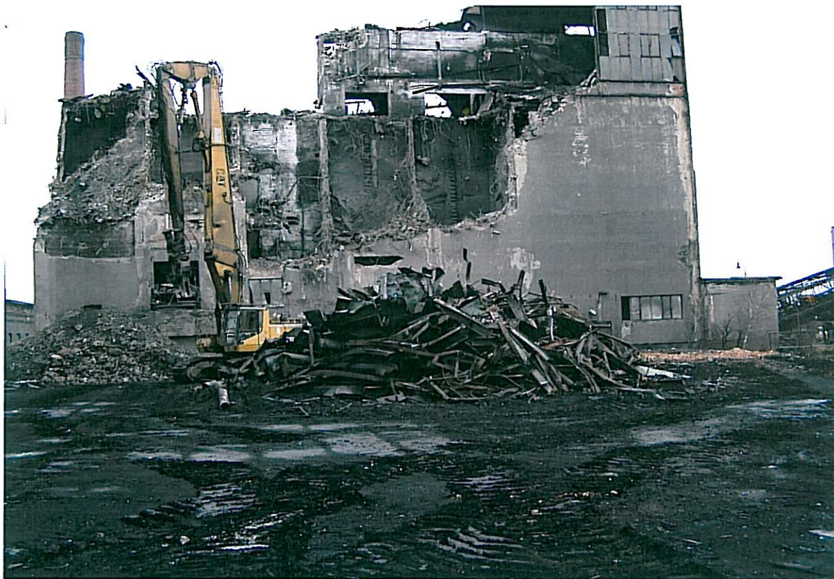
Průběh demoličních prací
