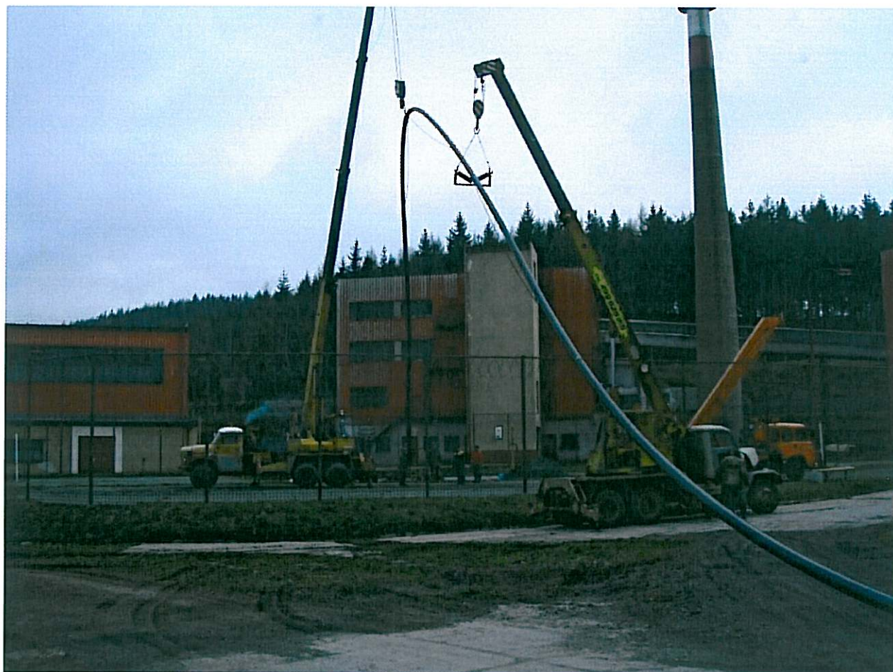
Spouštění plavícího potrubí do Odolovských jam
