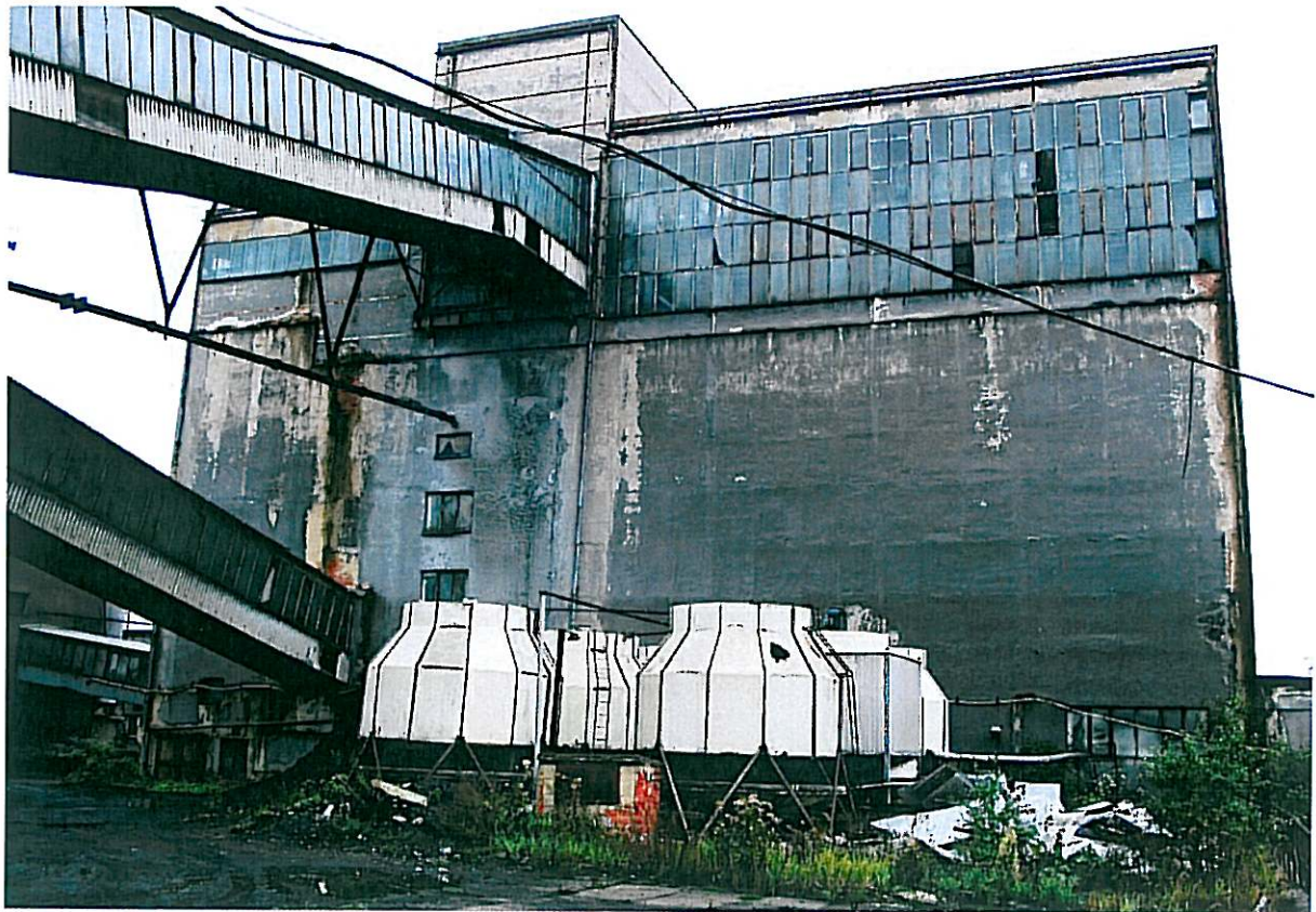
Objekt úpravny před demolicí
